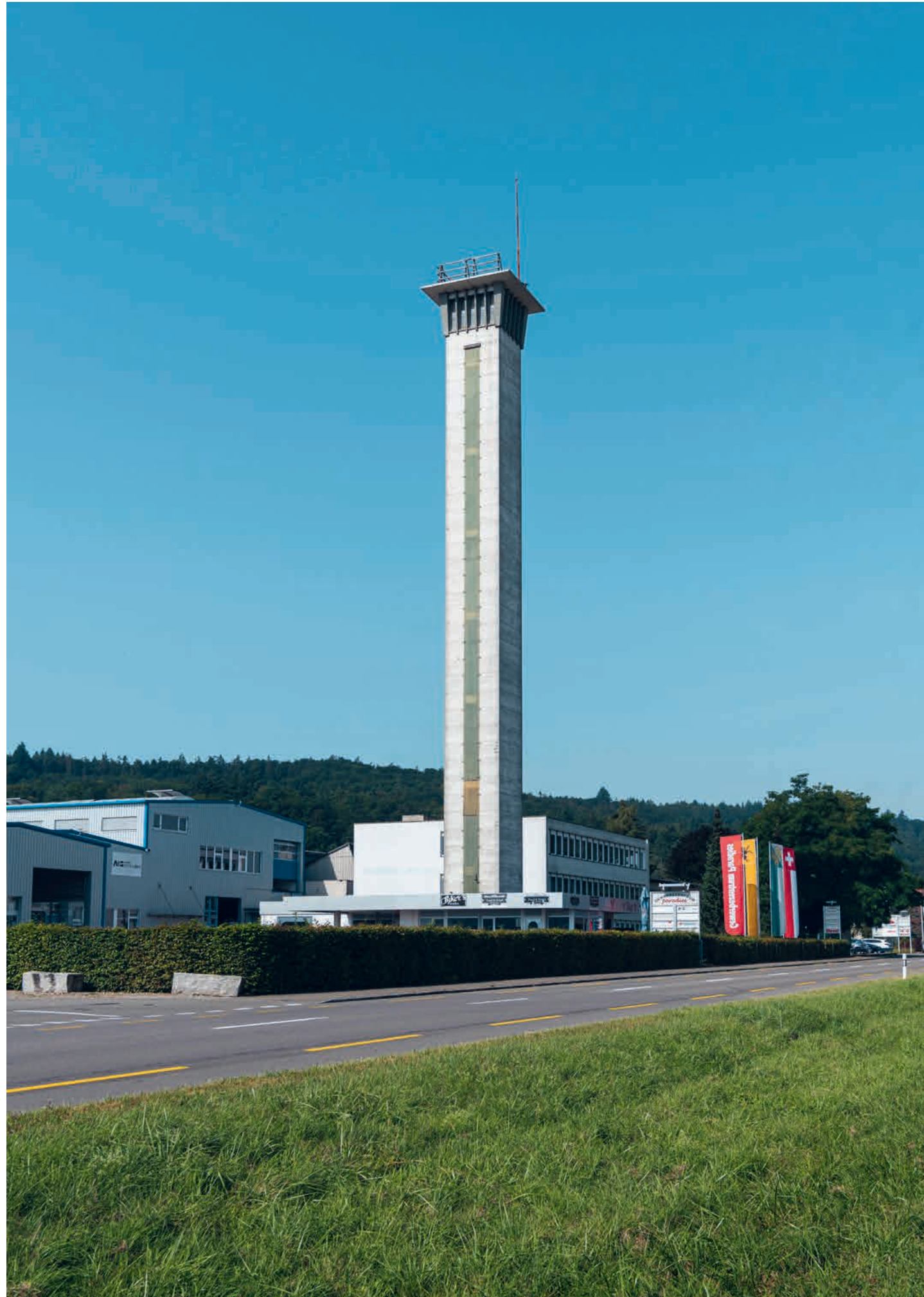
Der 45 Meter hohe Testturm in Schlatt im Kanton Thurgau: Hier wurden ab 1955 die AS-Lifte entwickelt, getestet und produziert.
