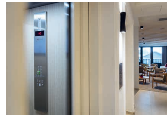
Bei der Sanierung des Hotels hat AS auch neue Lifte installiert.
